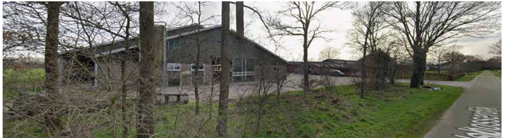
Straatbeeld B. Bron: Google street view
