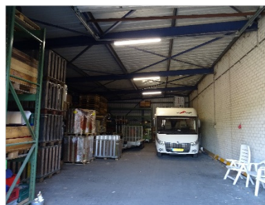
Figuur 2.6 Overzicht interne ruimte loods op onderzoekslocatie.
