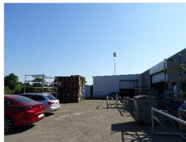
Figuur 2.4 Verharding, opslag en loods grenzend aan bedrijfsgebouw ten zuiden van de onderzoekslocatie.
