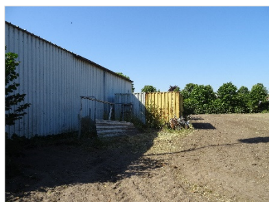
Figuur 2.6 Containers en loods voor opslag op de onderzoekslocatie.
