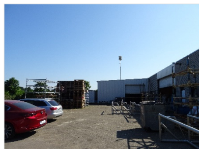
Figuur 2.5 Verharding, opslag en loods grenzend aan bedrijfsgebouw ten zuiden van onderzoekslocatie.
