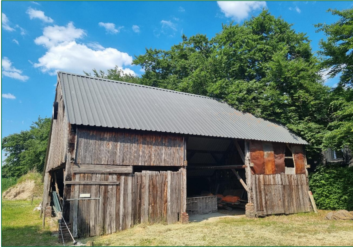
Afbeelding 32. Aanzicht te slopen schuur
