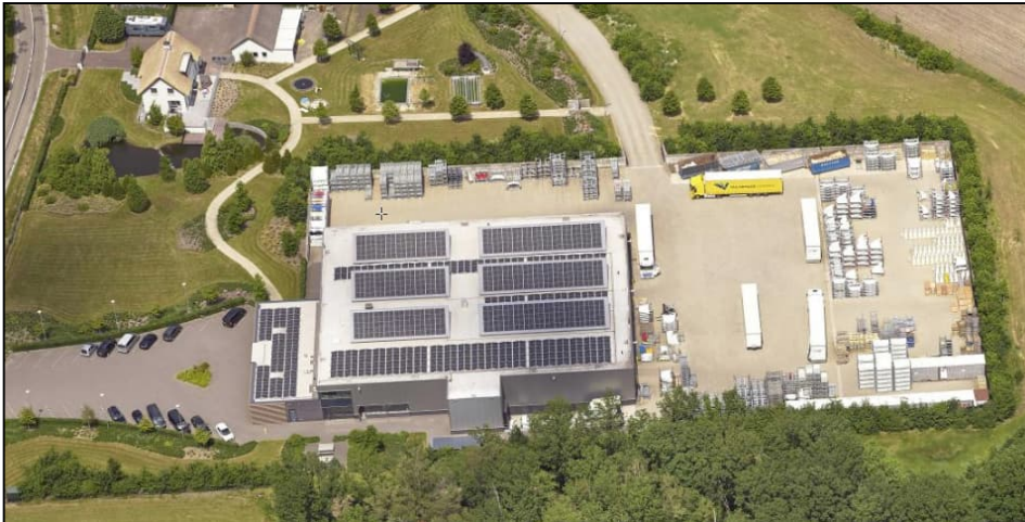
Figuur 5: (Lucht)foto Lommelsedijk 7-9, met in het noorden de bedrijfswoning met bijgebouw (Lommelsedijk 7) en in het zuiden de bedrijfsvoering (Lommelsedijk 9)
