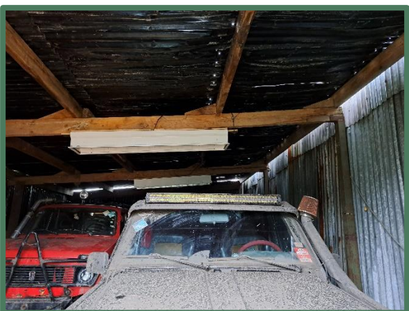
Binnenzijde golfplaten loods
