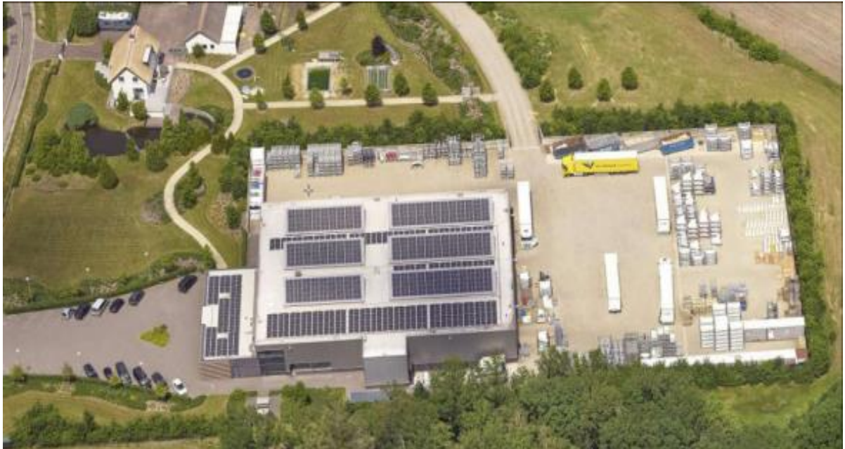
Bestaande situatie Lommelsedijk 7-9, met in het noorden de bedrijfswoning met bijgebouw (Lommelsedijk 7) en in het zuiden de bedrijfsvoering (Lommelsedijk 9). Bron: Crijns Rentmeesters
