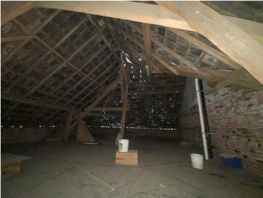
Figuur 7. Beeld van de zolder van het stalgedeelte van de woonboerderij.
