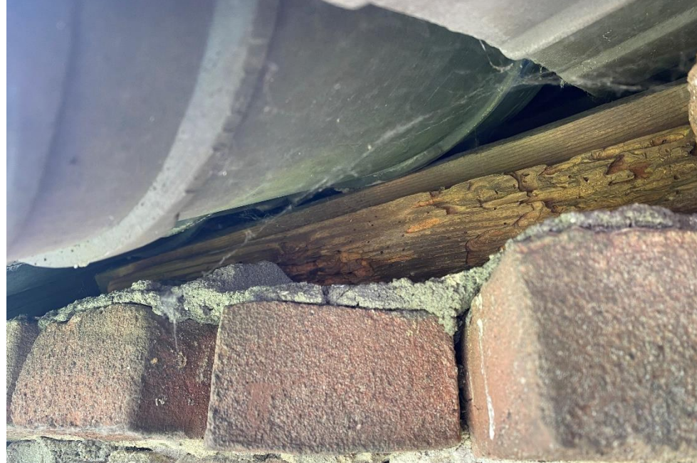
Figuur 18. Beeld van de aansluiting van de dakpannen op de gevel.
