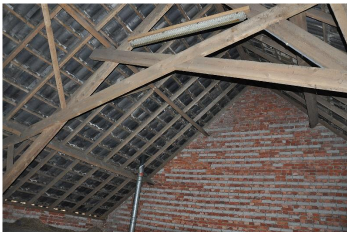
Afb. 31. Spant boven bedrijfsgebouw.
