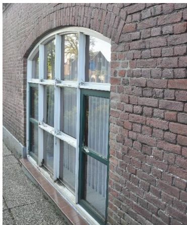
Afb. 16. De invulling van de gevelopening voor de potstal.
