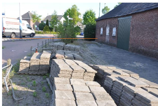
Afb. 7. Hoogteverschil weg en bedrijfsruimten.
