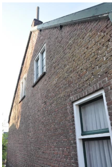
Afb. 17. De oostelijke zijgevel woongedeelte.
