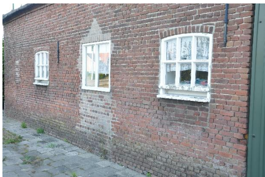
Afb. 18. De drie betonnen stalramen
