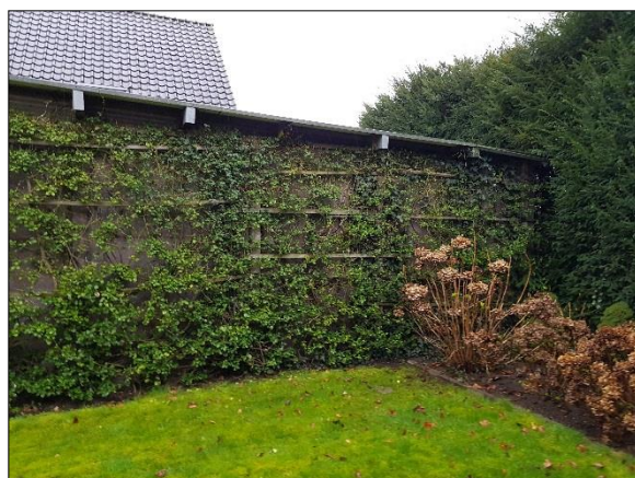
Figuur 9. Zijkant te slopen overkapping Dokter Rauppstraat 32 met nastgelegen heg
