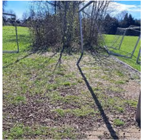
Fotonummer: 14 Omschrijving: Klinkerverharding tussen voetbalvelden
