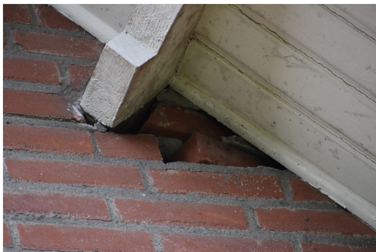
Figuur 4.1 Openingen naar de spouwmuur geschikt voor gebouwbewonende vleermuizen.
