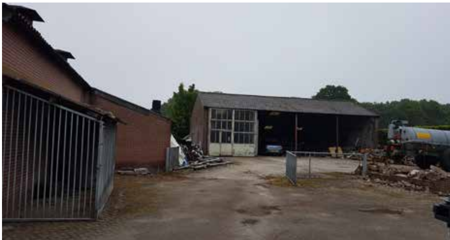
fig 3.4 Zicht op kapschuur, opslag, asbestplaten dak
