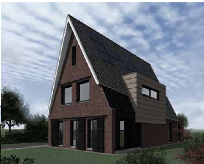
Referentiebeeld: simpele hoofdvorm met uitvergroot detail vanaf de goot, subtiel houtgebruik, antraciete pannen, bruinrode stenen, dakoverstek (bron: Swan Art & Build)
