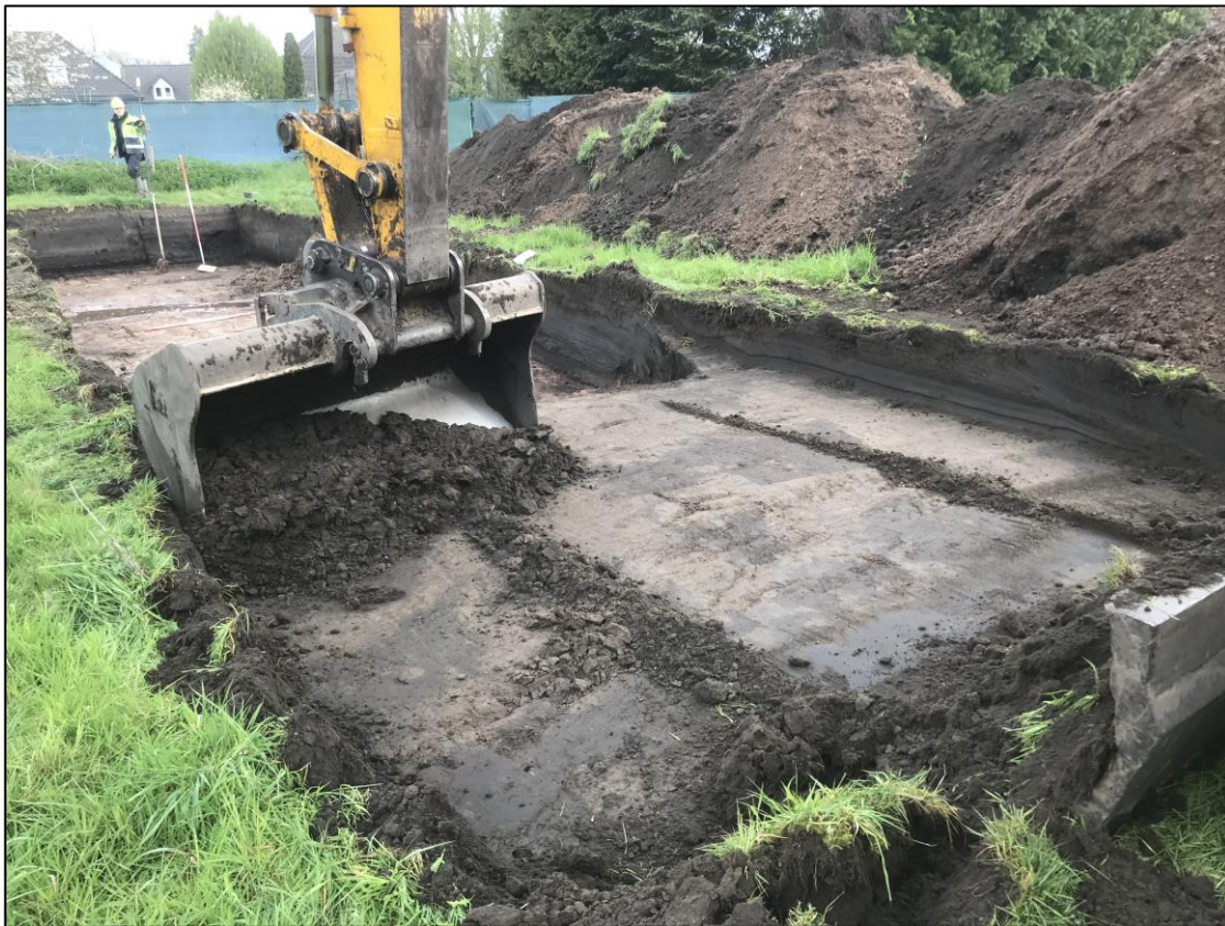
Figuur 3. Machinale aanleg van vlak 1 in werkput 1.
