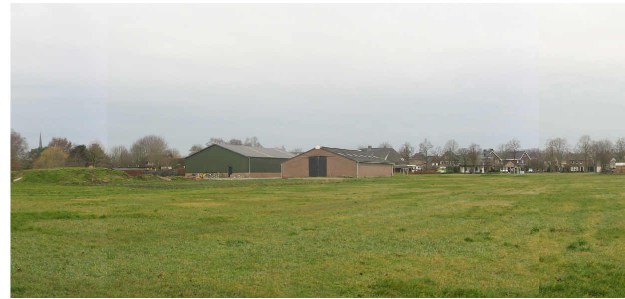
Zicht op achtererf, de rechterstal wordt gesaneerd
