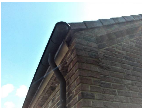
Hoekpunt en overhangende randpannen
