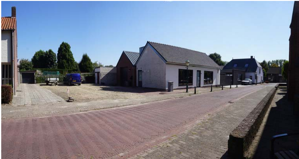
Bebouwing in 1 laag met kap op de hoek van de Kerkstraat en de Dorpstraat. Links het plangebied.
