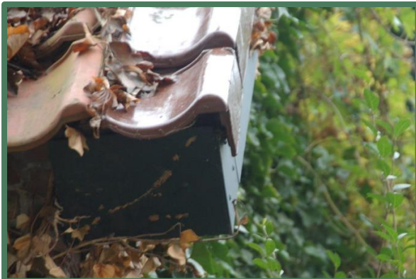
Openingen onder dakpannen
