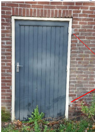
Afb. 9. De vernieuwde voergangdeur, thans in een houten kozijn.
