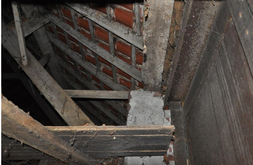
Afb. 32. Dakconstructie vanaf de begane grond gezien.
