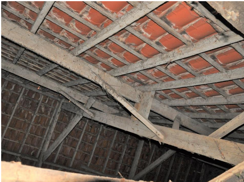
Afb. 33. het A-spant en gordingen.
