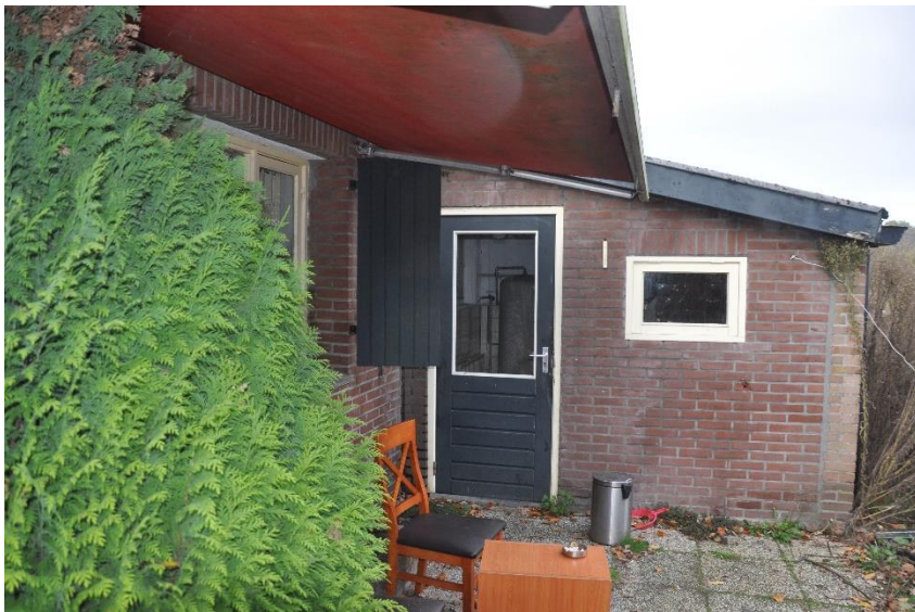
Afb. 17. De kopgevel van de aanbouw.
