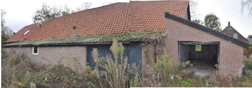
Afb. 16. Achtergevel met uitbouwen.
