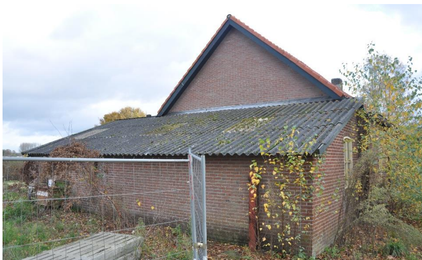
Afb. 11. De eindgevel vanaf straat gezien.
