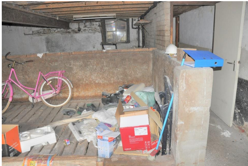
Afb.28. De voormalige koeienstal.
