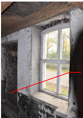
Afb. 8. Vroegere deur dichtgemetseld ( binnenzijde).
