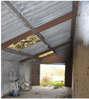
Afb. 34. De dakconstructie van de afhang.
