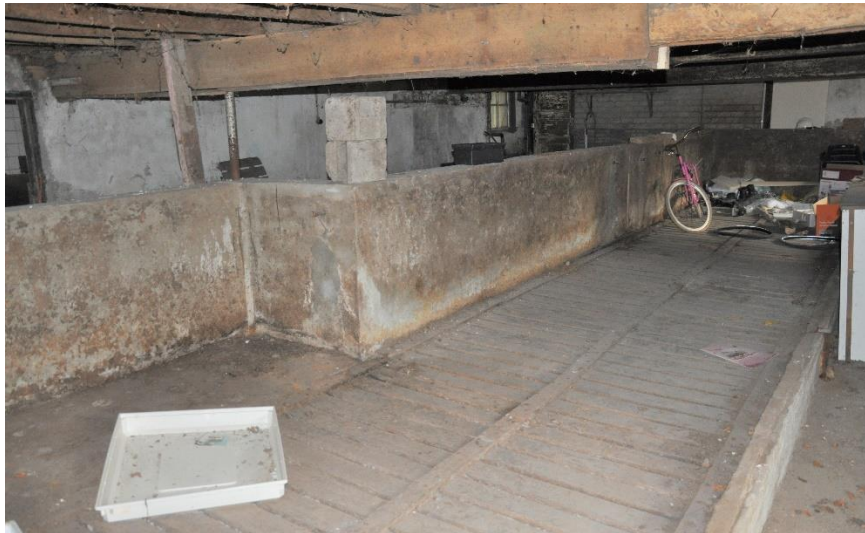
Afb.29. De eerdere varkensstal met roostervloer. Een door een stalen pijp ondersteunde moerbalk is ten behoeve van de toegevoegde zolder herkenbaar.
