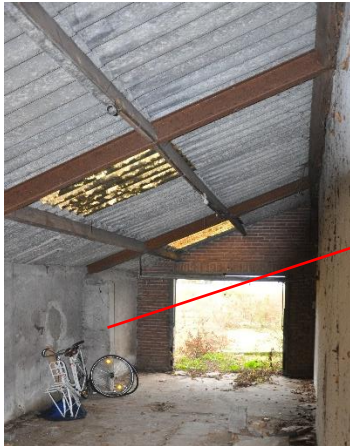
Afb. 12. Pilaster markeert de aansluiting van de uitbreiding aan de achtergevel
