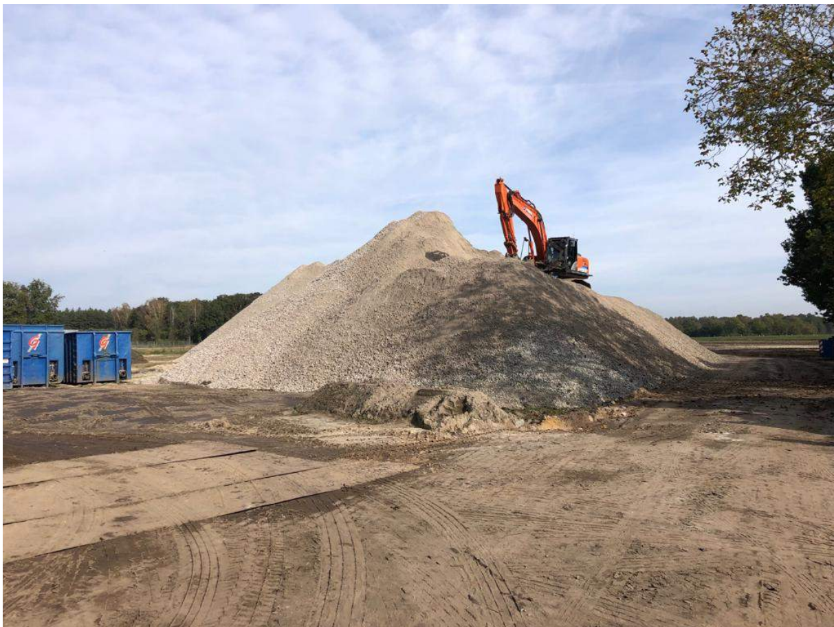
Figuur 22: Het noordelijke deel van het plangebied nabij boorpunt 6, gezien in noordelijke richting met op de voorgrond een grote berg sloopresten
