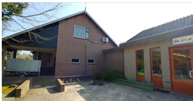
Figuur 8: Noordzijde van gebouwen centrale voorzieningen
