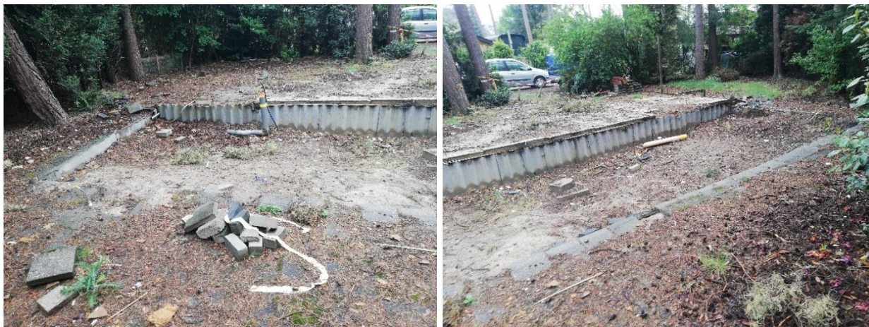
Afbeeldingen 7 en 8: foto's platen als beschoeiing op kavel 111 tijdens veldinspectie
