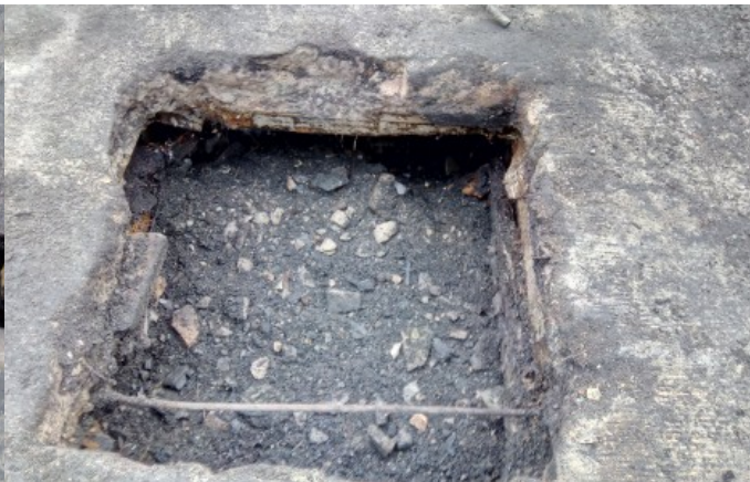
toelichting foto: kruipruimte
