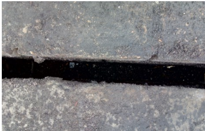
toelichting foto: kruipruimte
