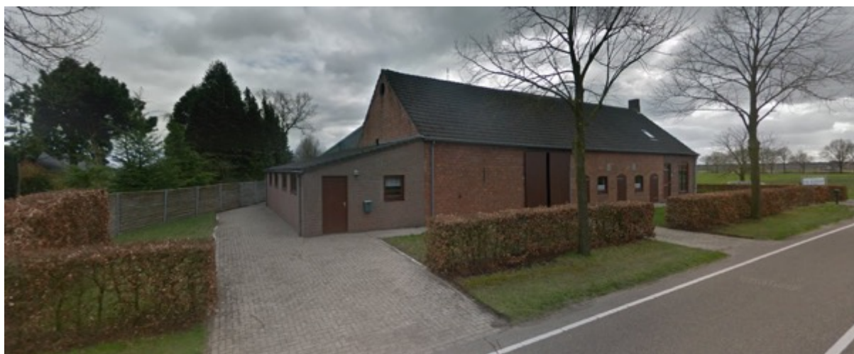
Luchtfoto met zich op bedrijfswoning vanaf Weebosserweg gezien, bron: GoogleStreetview
