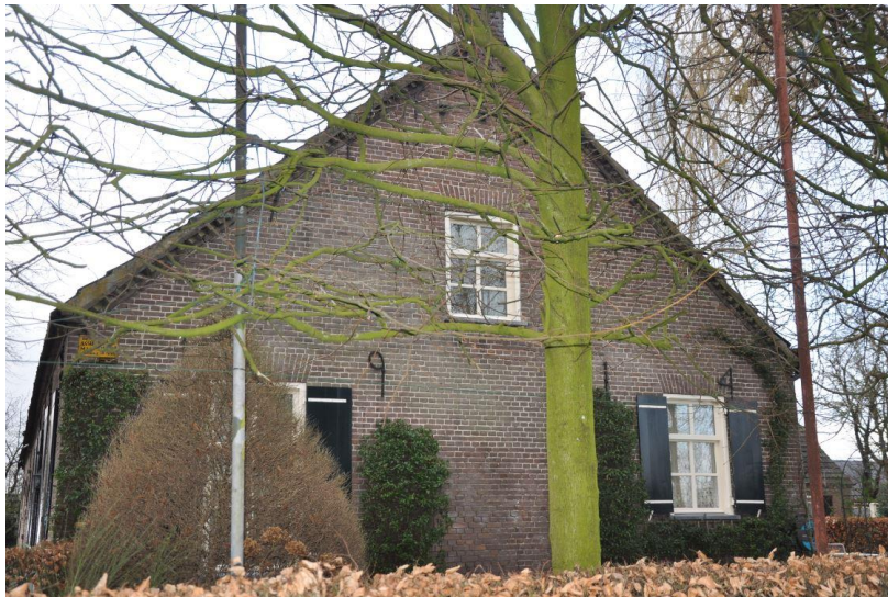
Afb. 18. Oostgevel met jaartalanker 1914.
