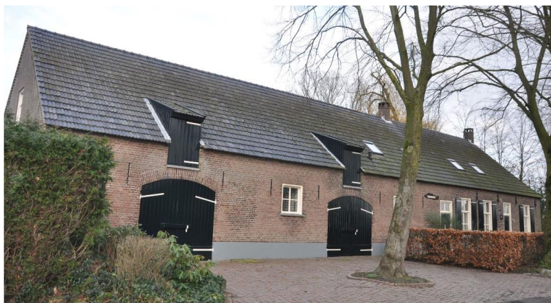
Afb. 17. De zuidgevel of voorgevel Rund 8 Bergeijk.
