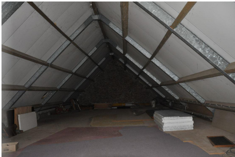
Afb. 40. Zolder met stalen spanten.
