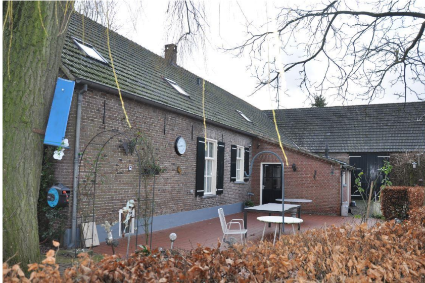
Afb. 19. Noord of achtergevel.
