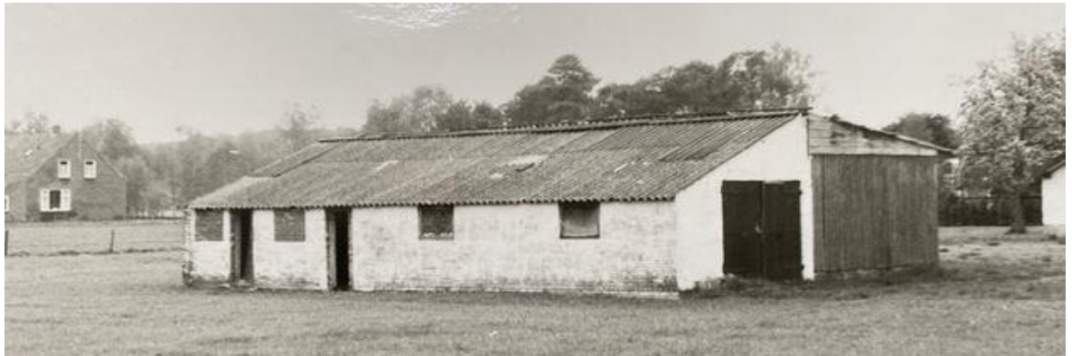
Afb. 23. De veldschuur, met varkensstallen en berging.
