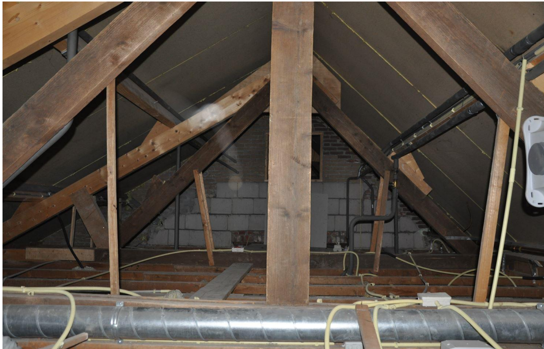
Afb. 67, Spanten, gordingen, en dakplaten boven het woongedeelte.
