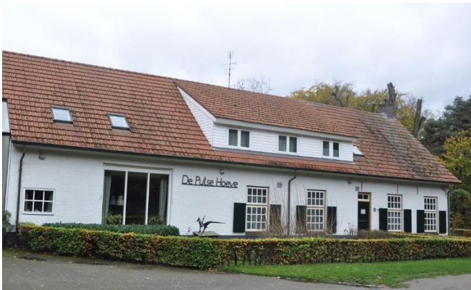
Afb. 35. De vervangende glazen pui
