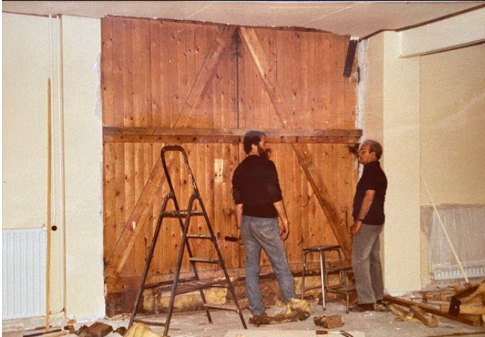
Afb. 34. De dubbele deur die vervangen is door een glazen pui.
