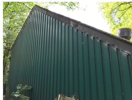
Achterkant kapschuur/ varkensstal
