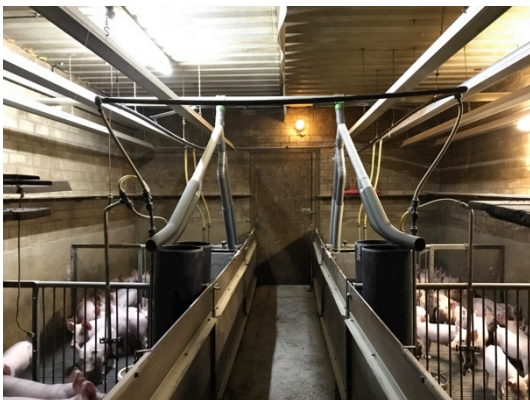
Schuren met stalen dakplaten in pandig geïsoleerd met Pur isolatie
