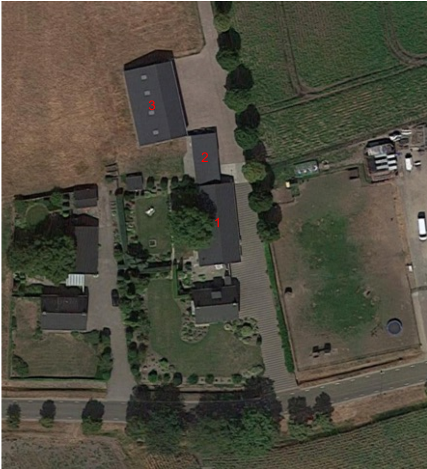
Luchtfoto met daarin aangeduid de verschillende gebouwen
