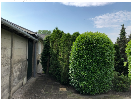
Achterzijde paardenstal (westzijde)
