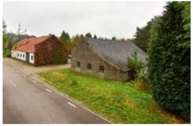
Woonhuis plus schuur
