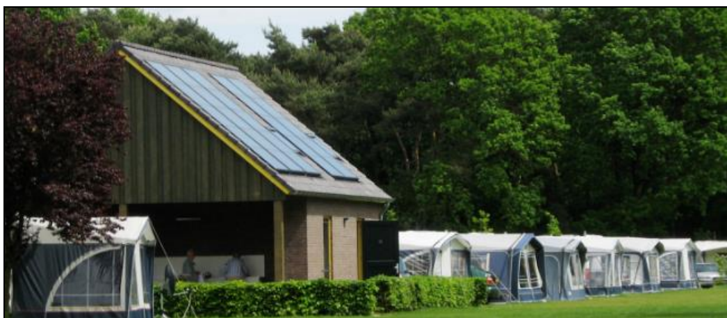
Figuur 4: Campingplaatsen en sanitaire voorziening
