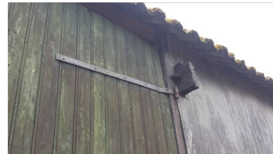
ankerbalk steekt door gevel
