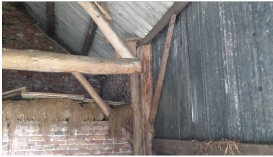
Gebintconstructie met muur en zoldering
