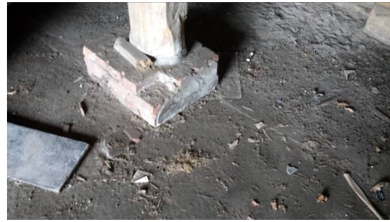
Gemetselde poer onder gebintstijl
