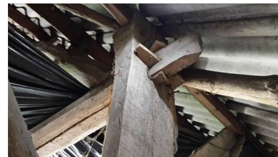
verbinding stijl - ankerbalk
