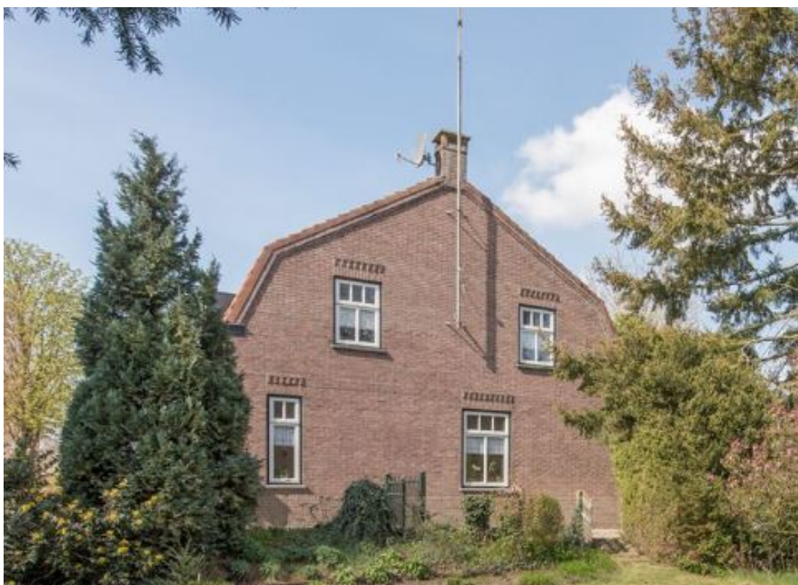
Afb.16. De kopgevel of oostgevel.
