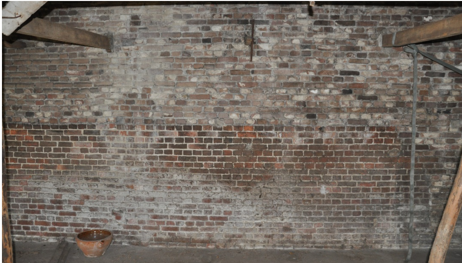
Afb. 21. geveldeel van de oorspronkelijke boerderij met daarboven een doorgetrokken gevel met hergebruikte baksteen.
