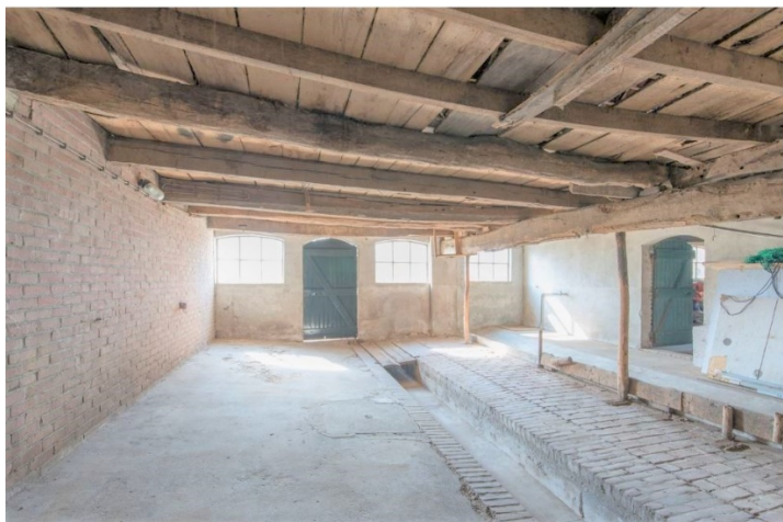
Afb.41. De koeienstal met zicht op straatgevel.
