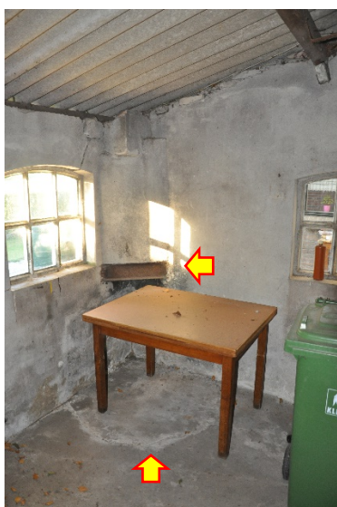
Afb. 20. Sporen van de voederketel en schouw.
