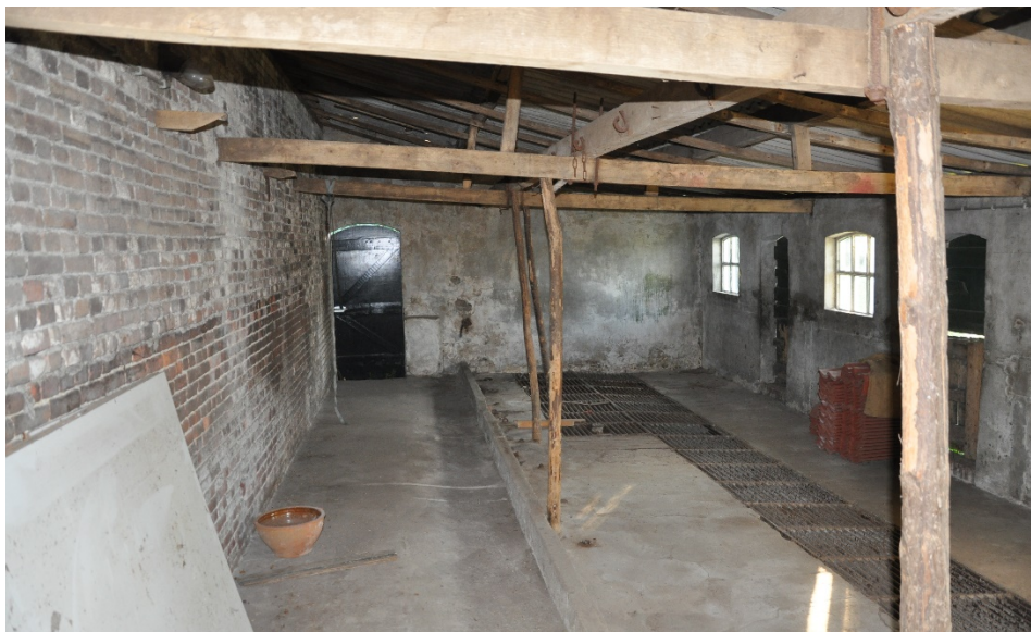
Afb.50. De dakconstructie van de aangebouwde varkensstal.
