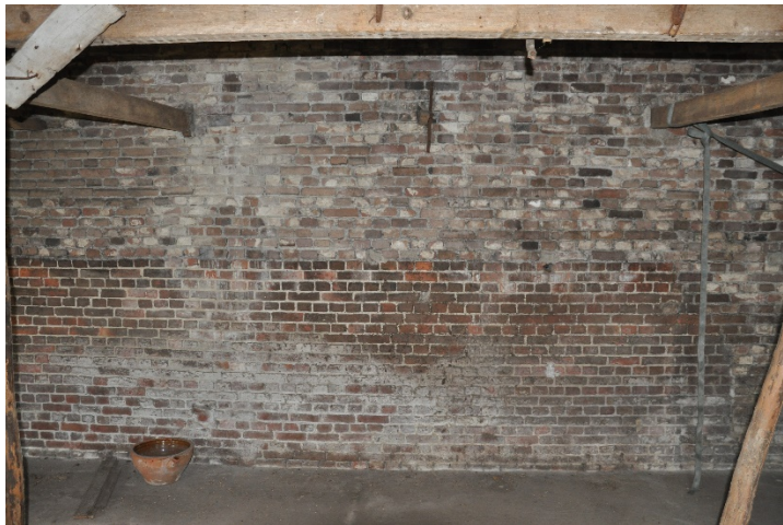
Afb.46. resten van de oorspronkelijke achtergevel met de latere verhoging met hergebruikte bakstenen.
