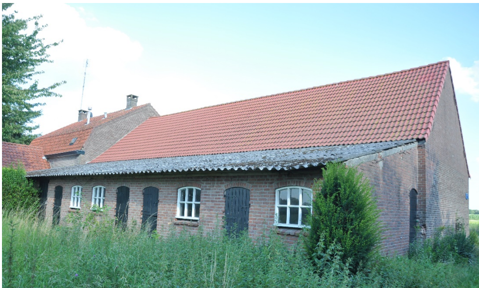
Afb.22. De achtergevel van de aangebouwde varkensstal
