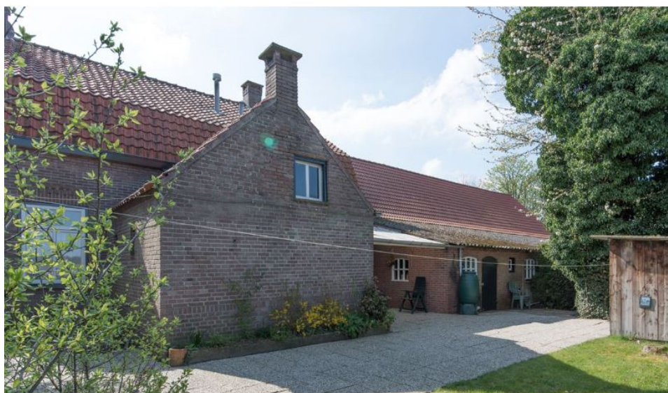
Afb.17. De achtergevel of noordgevel met de aanbouw van het woongedeelte.
