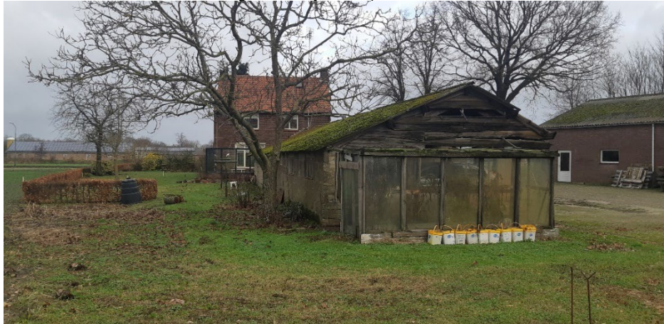
• Afbeelding 7: achterzijde te slopen schuur
