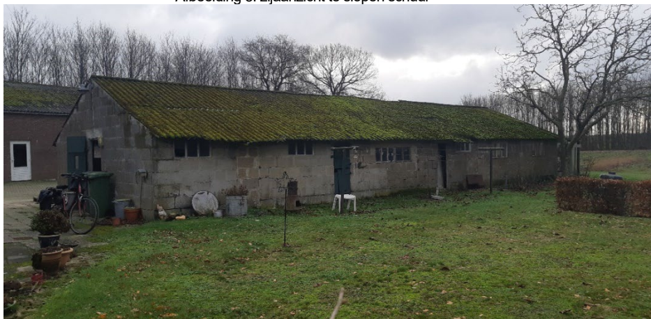
• Afbeelding 8: zijaanzicht te slopen schuur
