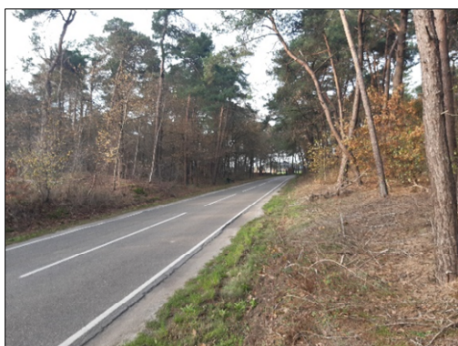
Figuur 2 (links). Impressie weg en wegberm. Datum: 25 november 2020.
