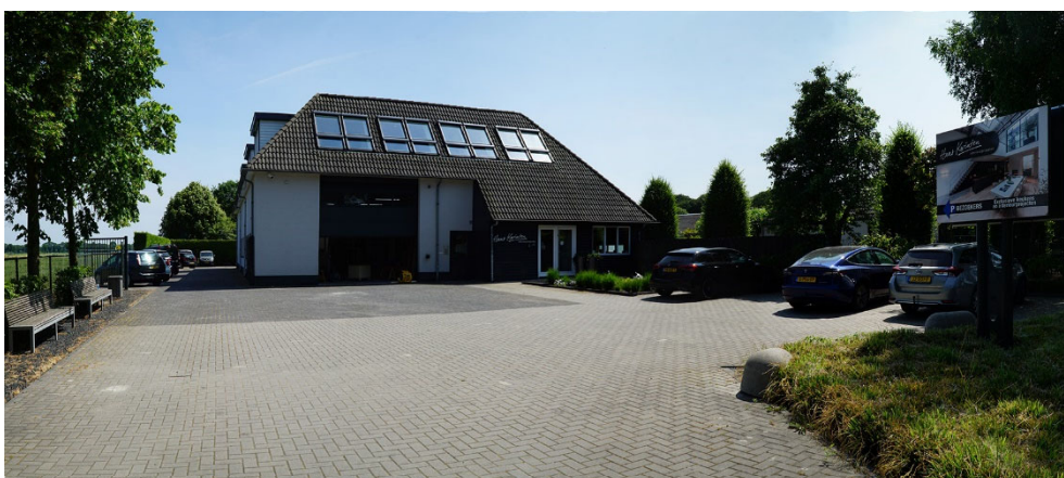
De bestaande bedrijfsbebouwing aan het Eykereind 94a
