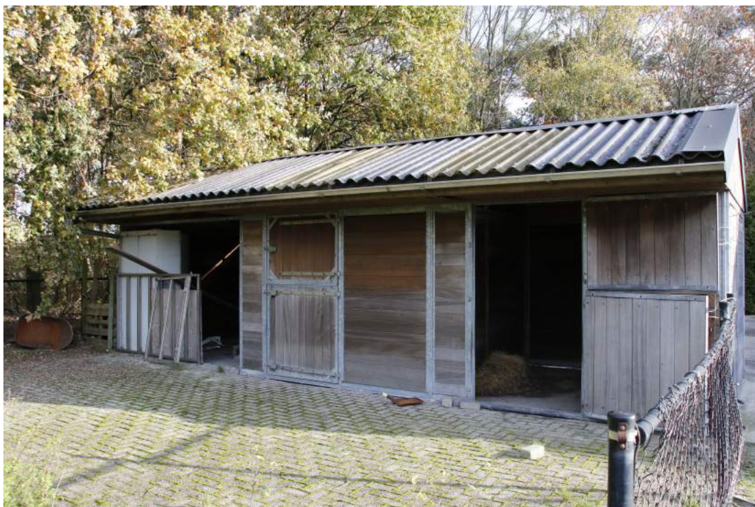
De voorzijde van de paardenstal. Het linkerdeel is permanent open en het rechterdeel is afgesloten door deuren. Het heeft een golfplaten dak zonder geschikte ruimte voor verblijfplaatsen van huismussen en vleermuizen. Foto: K. de Vries | Ecoresult BV
