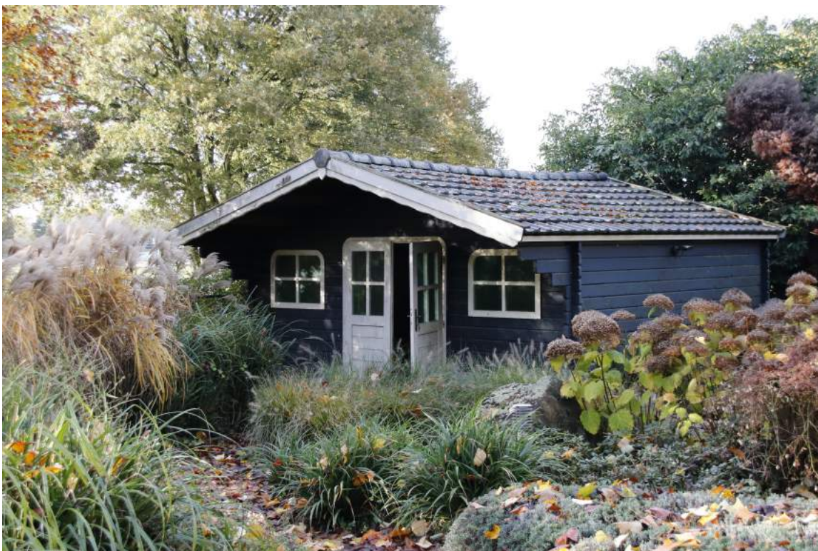
Het houten tuinhuis. Dit gebouw bestaat geheel uit hout met een platte dakpannen dakbedekking. Het dak steekt aan de voorzijde uit en heeft geen dakgoten. Kieren, gaten en holtes zijn in en om het dak afwezig. Foto: K. de Vries | Ecoresult BV.
