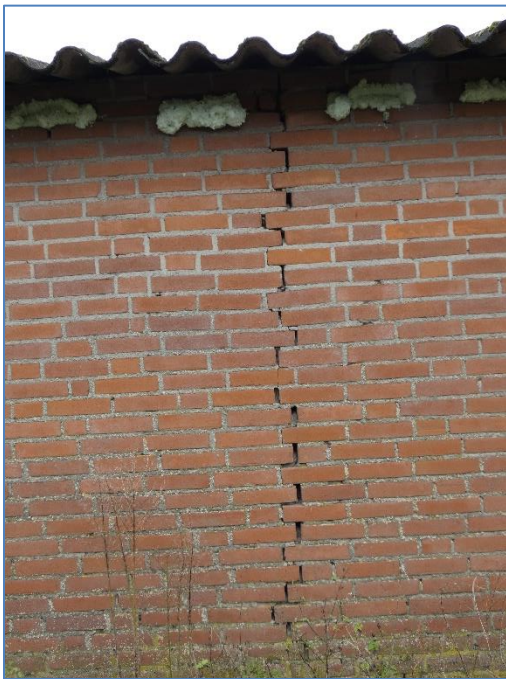
Foto 28 en 29 scheur in ZW gevel gebouw 6
