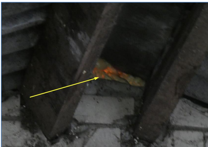
Foto 7 PUR afdichting nok gebouw 7
