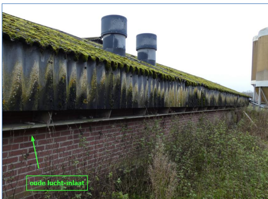
Foto 10 Oude zij-inlaat lucht gebouw 6 (NO zijde) ; met vochtige beplating en veel tochtige omstandigheden.
