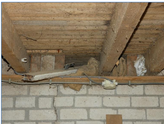
Foto 20 niet onderschoten zolder gedeelte gebouw 5
