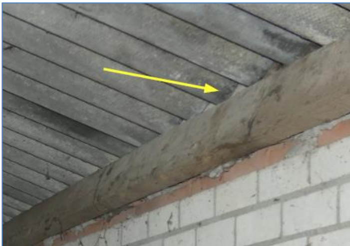
Foto 6 'plaat-golfafdichting' gebouw 7
