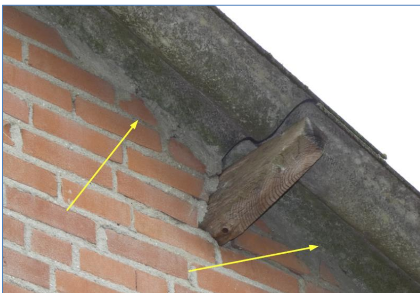
Foto 8 kopgevel afdichting met cement tegen de platen gebouw 7
