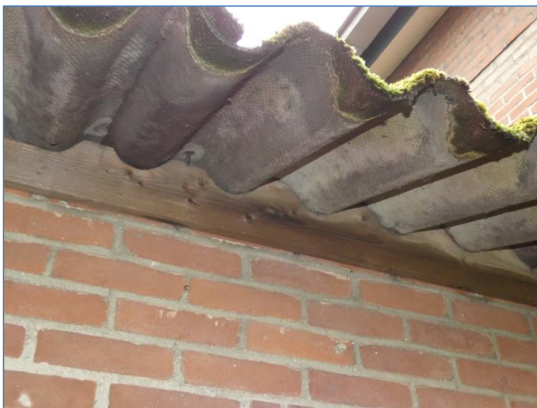
Foto 23 Golfplaatafdichting tussengebouwtje gebouw 1 en 5
