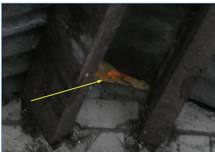
Foto 7 PUR afdichting nok gebouw 7
