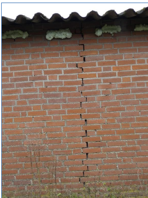
Foto 28 en 29 scheur in ZW gevel gebouw 6
