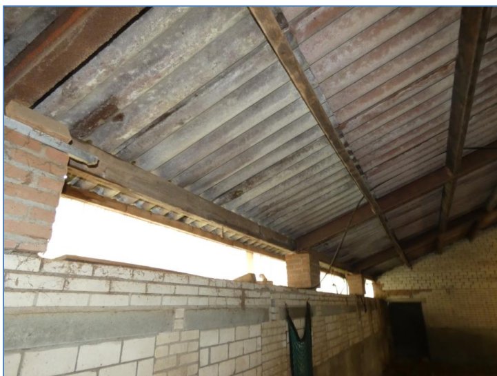
Foto 17 behoorlijk open zijgevels gebouw 3
