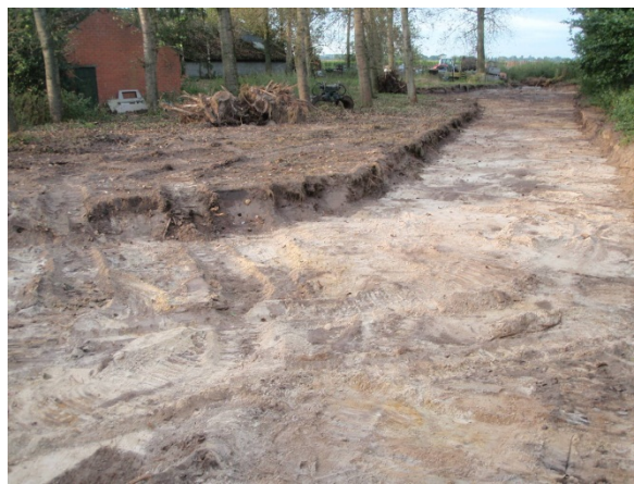
Foto 4: Zicht op putbodem P16 en P17. Links de wand W16.
