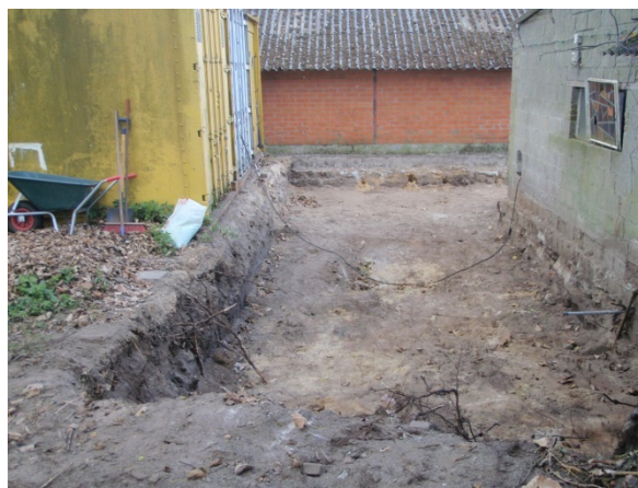
Foto 6: Zicht op aanvullende ontgraving ter hoogte van P12. Links onder de containers (W12) blijft een restverontreiniging achter.
