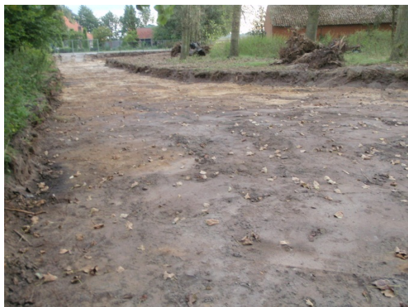
Foto 3: Zicht op putbodem P15. Links de wand W18 en rechts wand W16.
