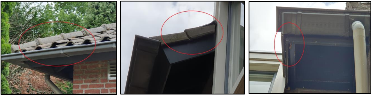
Foto's: Potentiële toegangsmogelijkheden voor vleermuisverblijfplaatsen in de te slopen bedrijfswoning.
