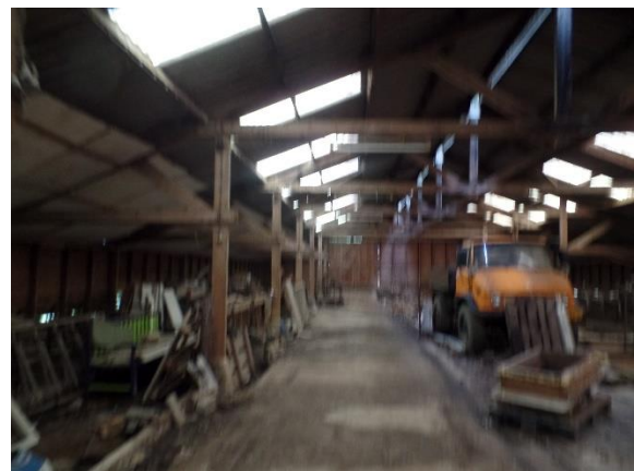
Fig.5. Binnenkant grote houten schuur
