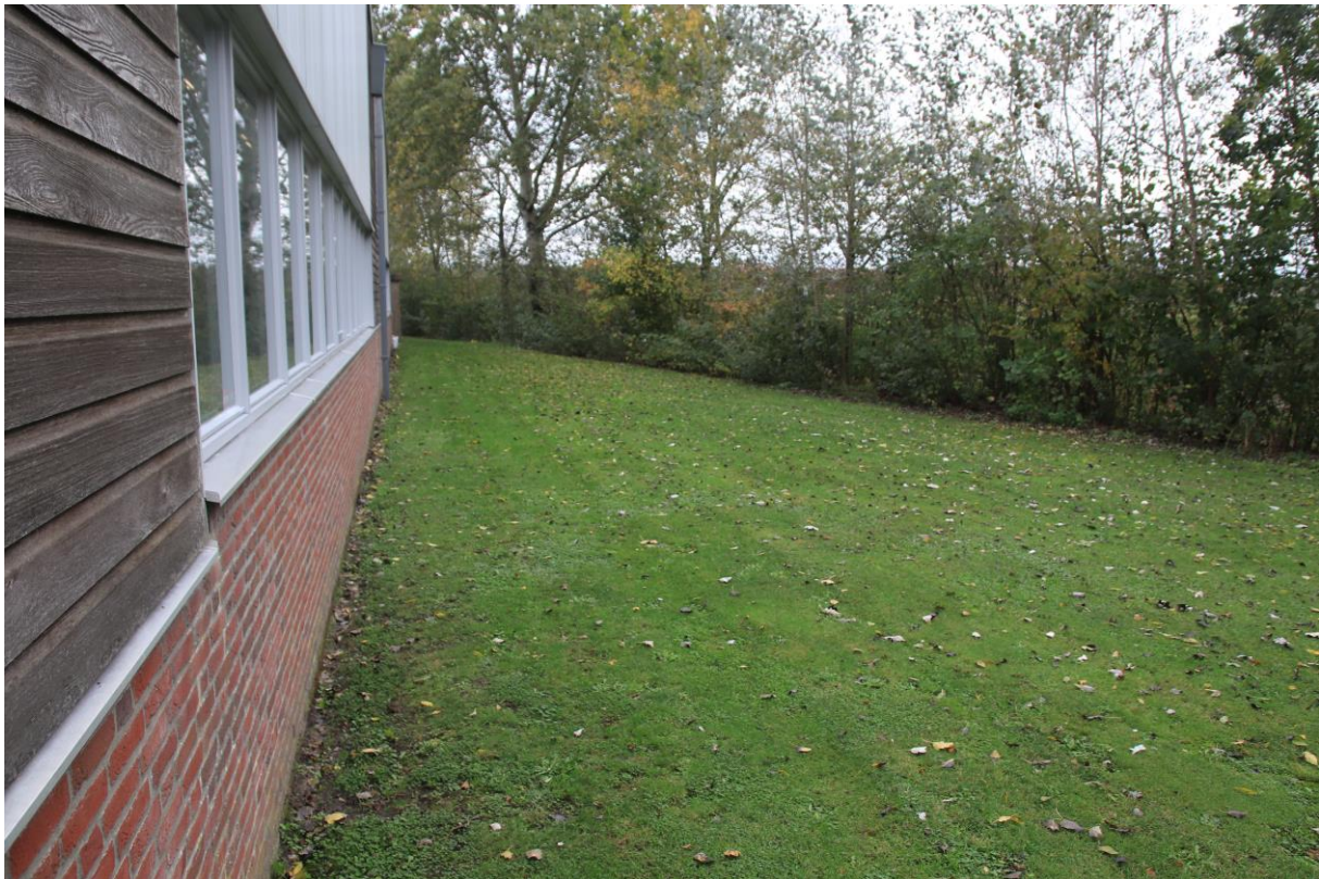
Foto 2: beoogde locatie voor de waterberging (regenwateropvang)
