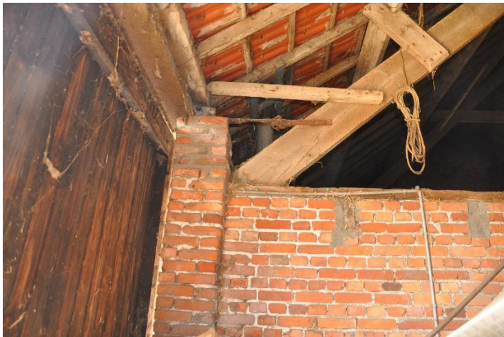
Afb.49. De grote open ruimte met slof en spantbeen en ondersteuning gording.
