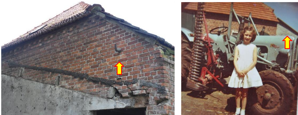
Afb. 23. en 24. Het anker voor de bevestiging van een balk tegen de gevel, waarop de daksporen van een afgang getimmerd werden en zijgevel afgang boven trekker.
