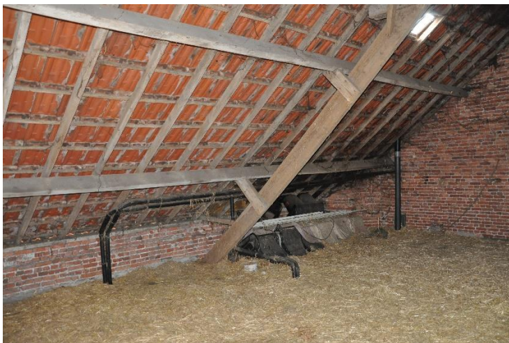
Afb.47. De hooizolder met lage borstwering.
