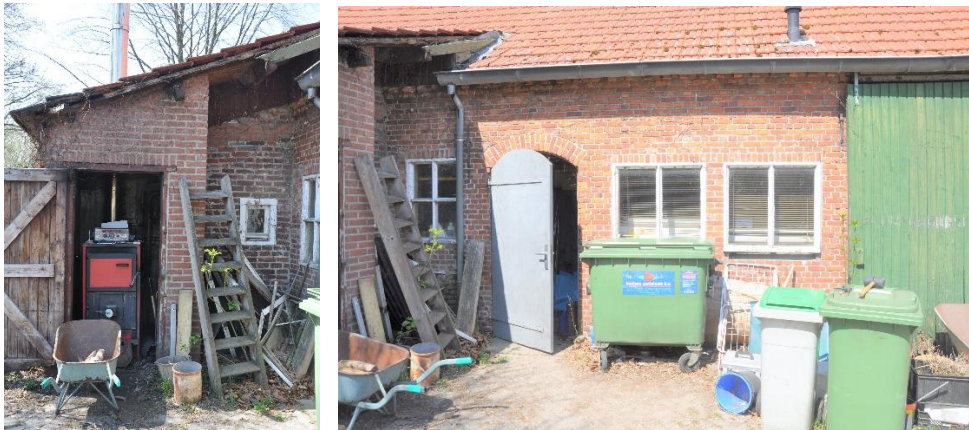
Afb.18. en 19. Aangebouwde stookruimte en geveldeel zuidgevel.
