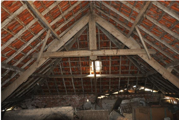
Afb.48. De hooizolder met kapsant, rechts ophoging onder gording.
