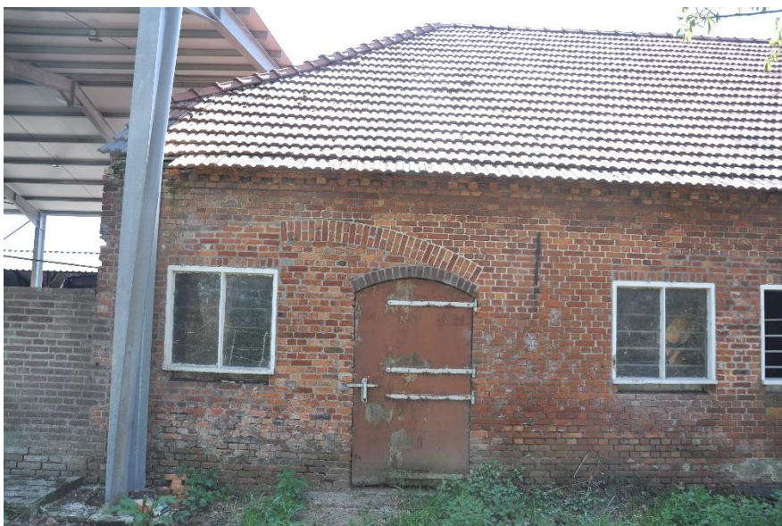
Afb.22. De noordoost hoek van het stalgedeelte met bouwsporen van een eerder gebruik.
