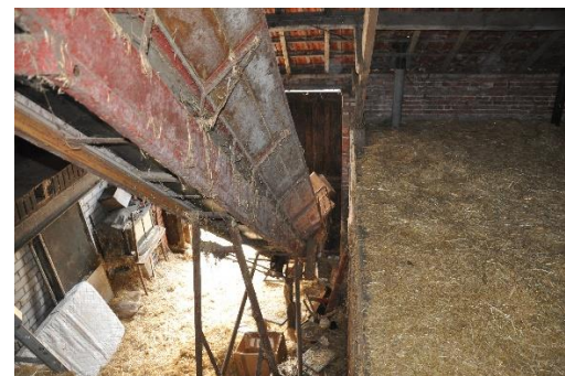
Afb. 40. en 41. De grote open ruimte met transportband om stro en hooi naar de zolder te transporteren (van beneden en boven gefotografeerd.)
