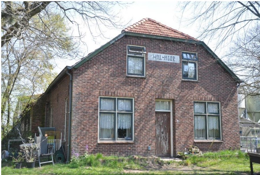
Afb.13. de kop- of westgevel .
