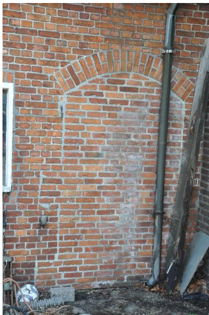
Afb.20. Authentiek bouwspoor staldeur zuidgevel.
