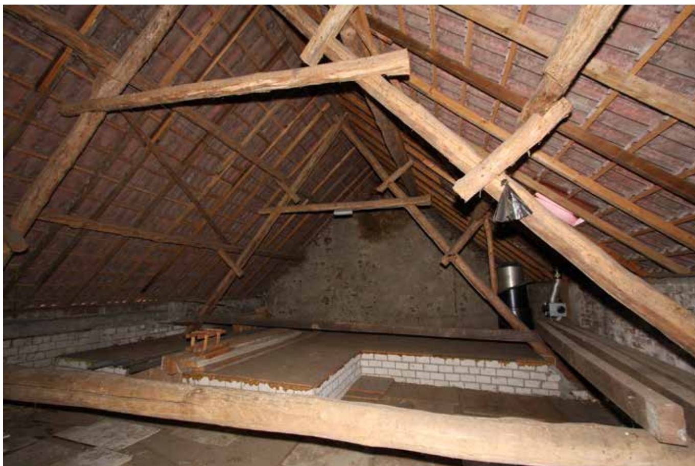
zolder richting brandmuur
