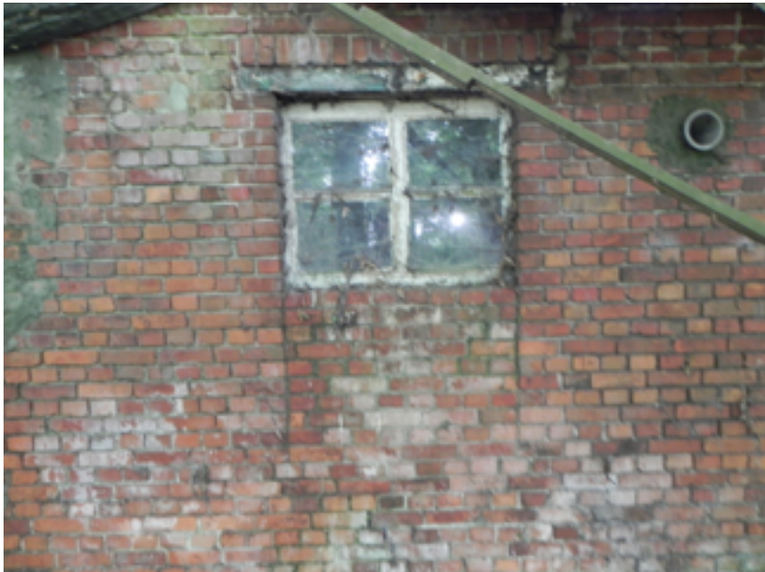
29. Oude huis (2) dichtgezet woonhuisvenster in voorgevel. JvL 2014
