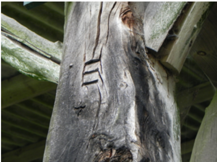
38. De houten constructie heeft gehakte telmerken en pen-gatverbindingen. JvL 2014
