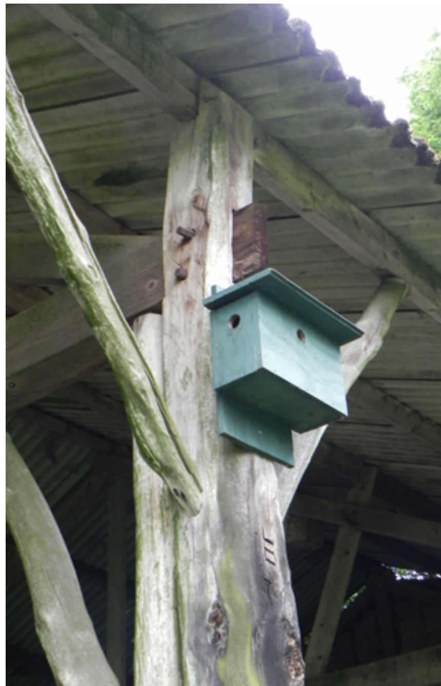
45. Stijl van het ankerbalkgebint (gebouw 3) met pen-gatverbinding en gehakte telmerken. JvL 2014
