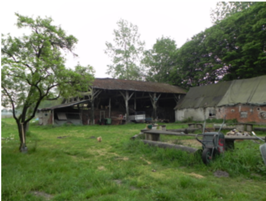
39. Zicht op het erf gezien richting de open hooischuur (3). JvL 2014
