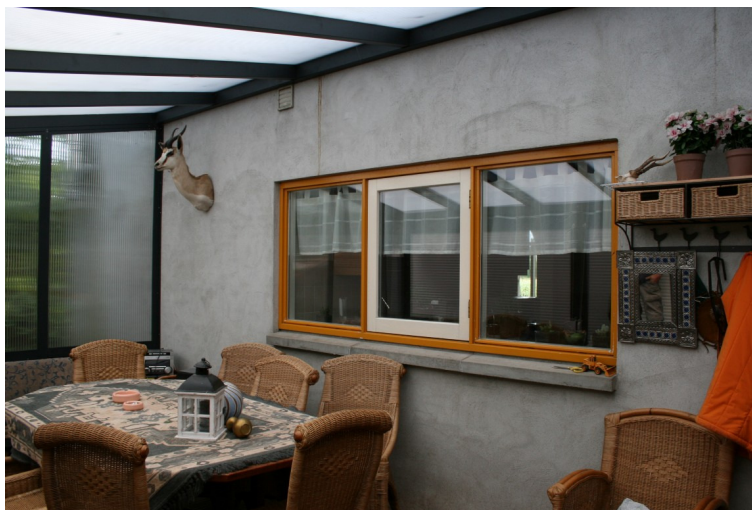
Oorspronkelijke achtergevel in de serre
