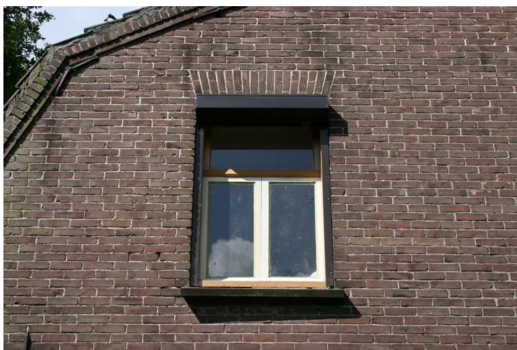
Detail venster op de verdieping
