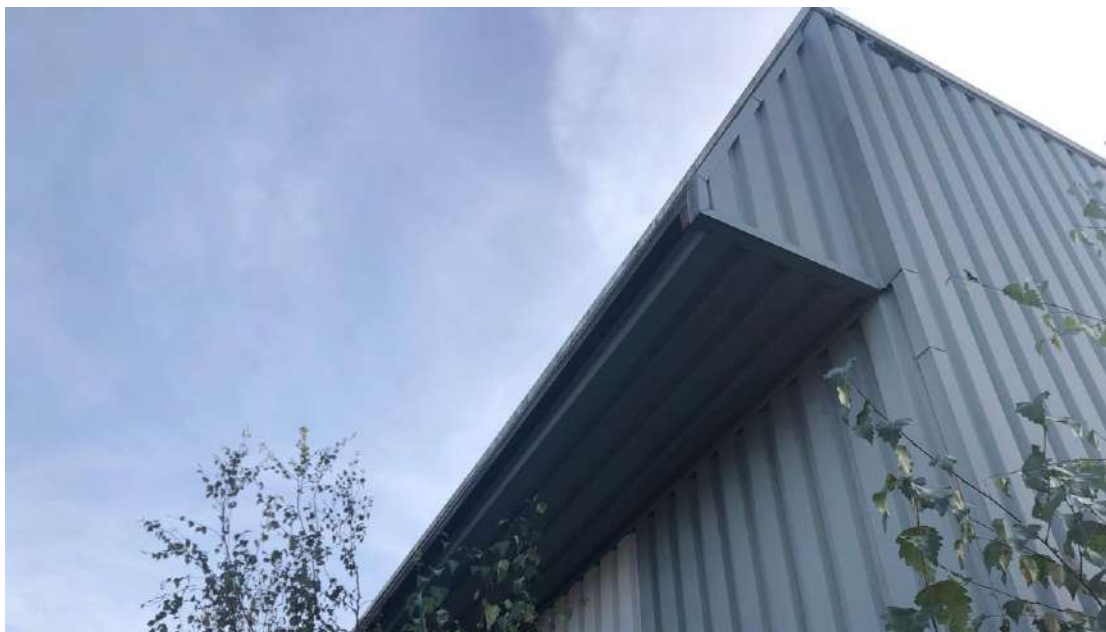
Figuur 5q: Driehoekige constructie met open frontrichel gebouw 1.
