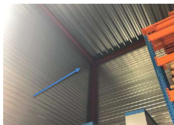
Figuur 5f: interne enkelwandige plaatconstructie.
