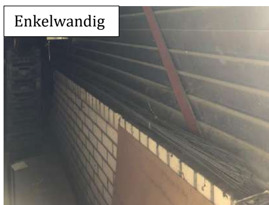
Figuur 5e: interne enkelwandige plaatconstructie.
