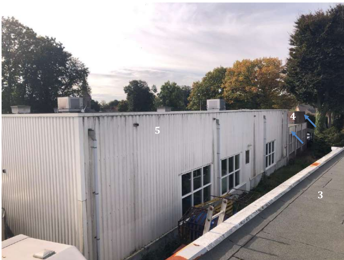
Figuur 5i: Zicht op gebouwen 5 en 4 gezien vanaf dak gebouw 3. Blauw pijlen: zie onderstaande figuren voor details.
