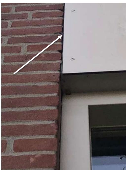
Figuur 5j: Afgesloten kieren tussen muur en trespa.
