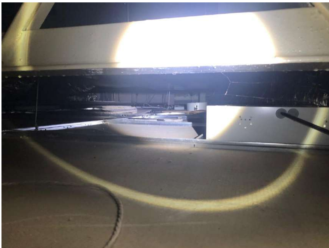
Figuur 6e: Plafonniere inspectie restauratie – vergaderruimte gebouw 3. . Géén diersporen anders dan enkele muizenkeutels aangetroffen.
