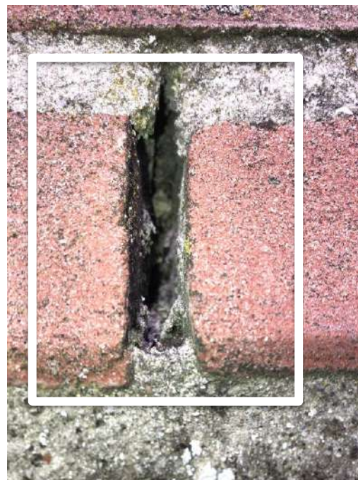
Figuur 5n: gesloten "open stootvoeg".
