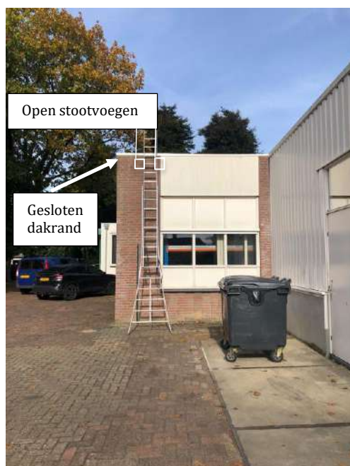
Figuur 5m: Enkele gesloten "open stootvoegen".
