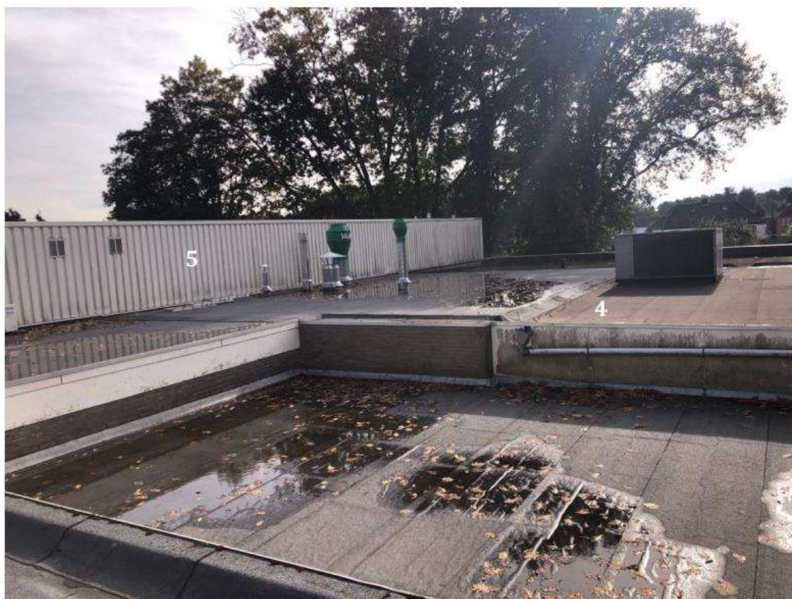
Figuur 5p: Overzicht daken 4 en 5. Géén entree mogelijkheden.
