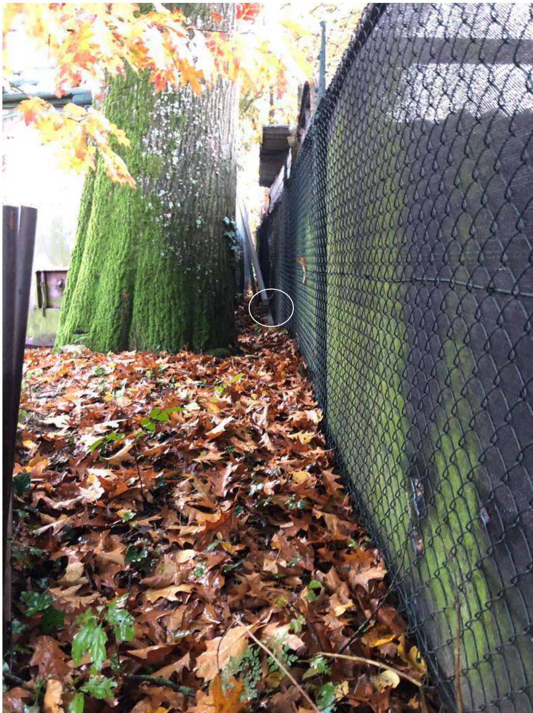
Figuur 4b 2: Camerapositie 2 met zicht op een deel van het hekwerk langs het zuidelijke deel van het terrein.
