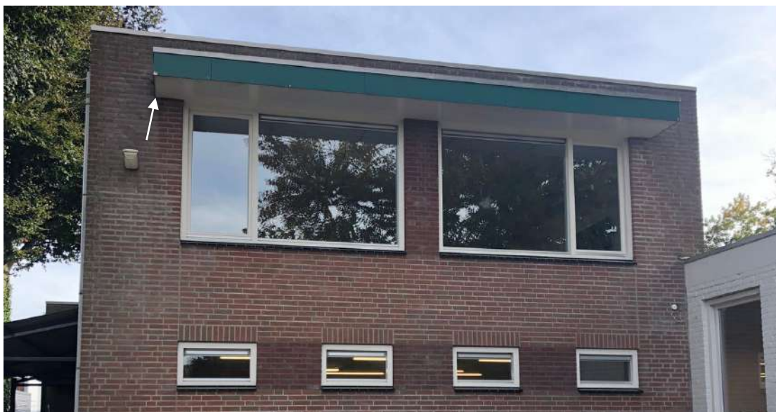
Figuur 5l: Goed afgesloten overstek aan het front van gebouw 4 (kantine deel).
