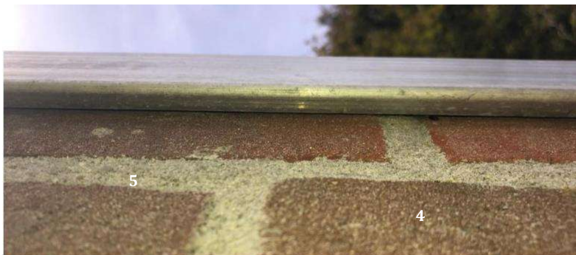
Figuur 5o: Geloten dakrand gebouw 4. Alle muren van steen met een plat dak zijn voorzien van goed afgeloten randen.
