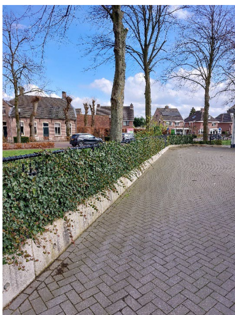
Afbeelding 4: In recent verleden geplaatste L elementen met onder de verhardingslaag een diepe puinfundering (ophoging)
