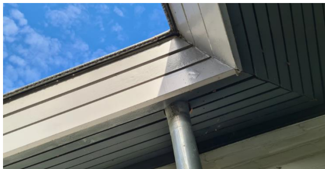
Figuur 8: Detailopname dakrand
