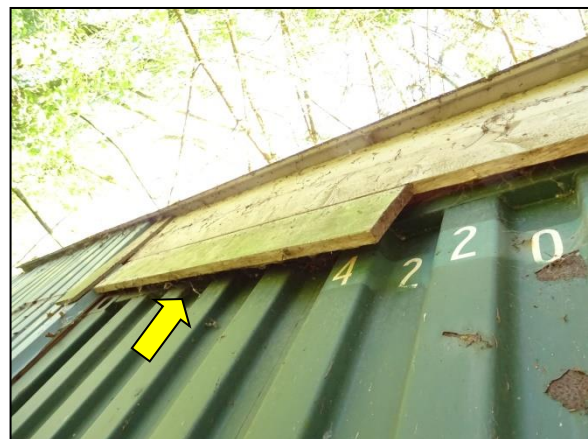
Figuur 12. Ruimtes onder betimmering van containers.
