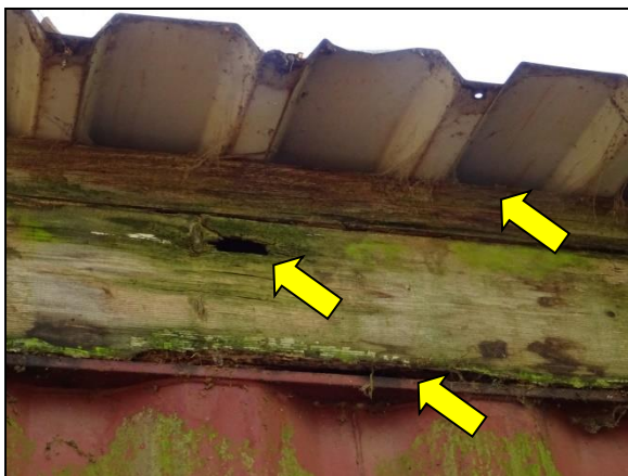
Figuur 11. Ruimtes bij dakrand van de containers.
